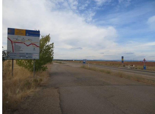
Primer punto conflictivo y peligroso. Mientras el Camino declarado prosigue en su trazado por el vial paralelo a la carretera, las señales indican el peregrino que debe girar 90° y pasar al otro lado de la carretera. Es un punto relativamente cercano a una curva en subida de escasa visibilidad, donde los vehículos se encuentran con los caminantes en poco más de 200 m.
