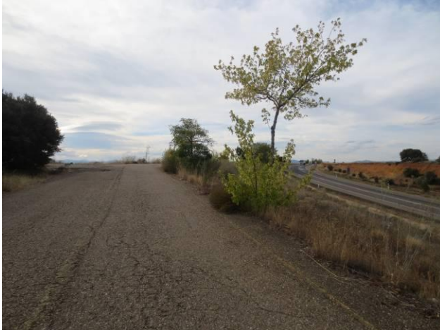
El Camino de Santiago (izquierda) es paralelo a la carretera N120 (derecha) en la entrada al término de San Justo de la Vega.
