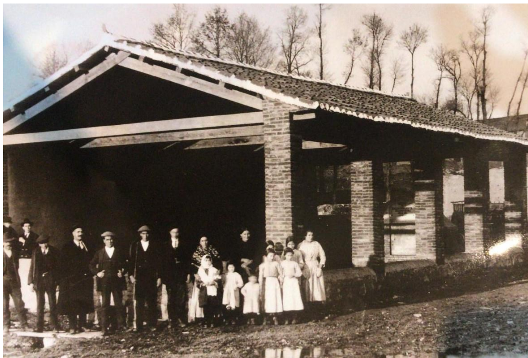
Figura 03. Antiguo lavadero cubierto.
