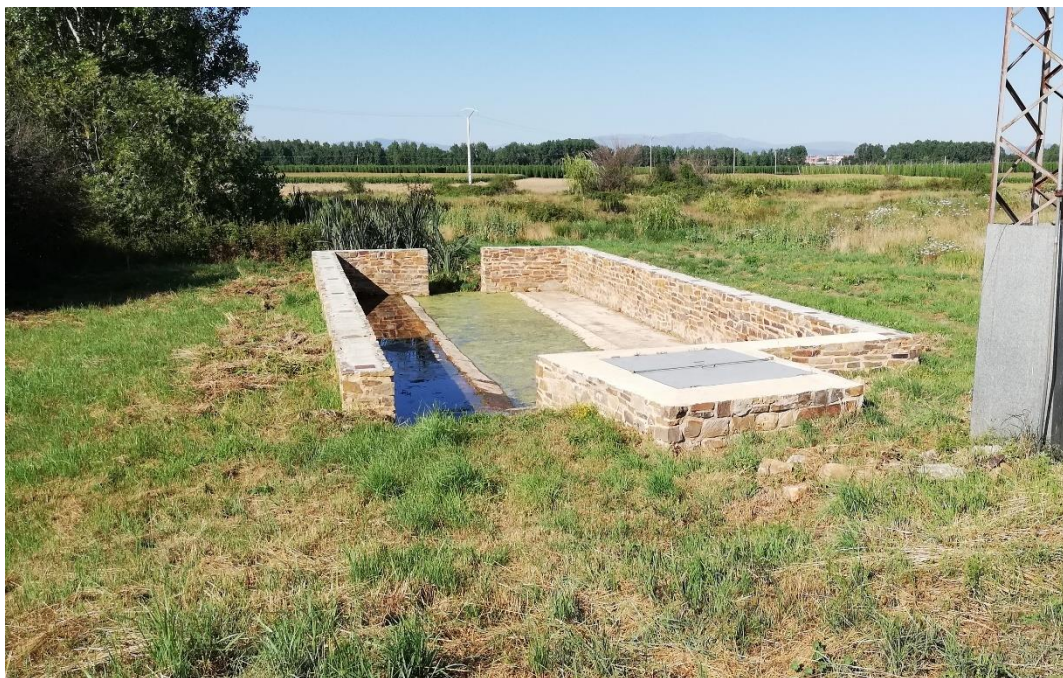
Figura 02. Estado actual del lavadero.
